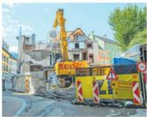
Die Abrissarbeiten der Einbaubühnen für die Kirche gehen wie immer zügig voran.
